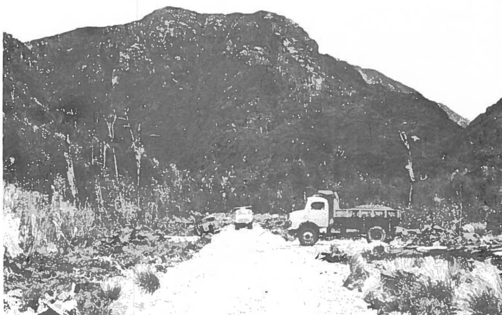
FIG. 8. Sección basal de terraplén terminada.
